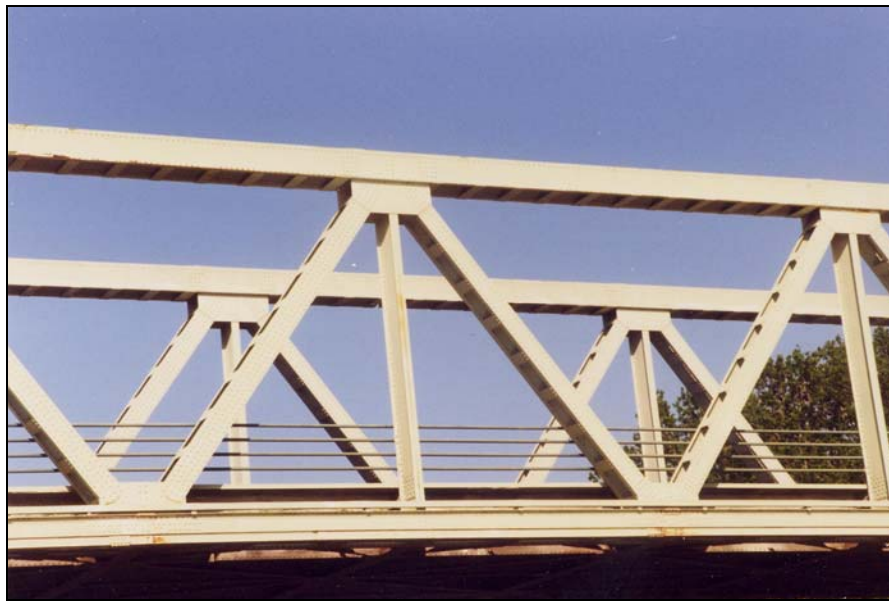
Passerelle composée de deux treillis métalliques parallèles sur le Rhône en France : les nœuds sont rigides et très ramassés. (Photo de l'auteur)
