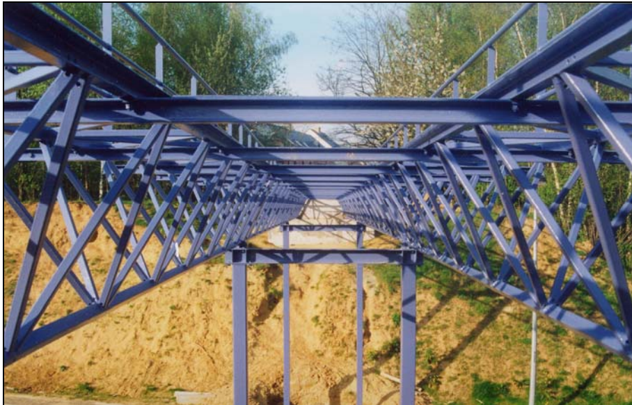
Passerelle composée de deux treillis métalliques tridimensionnels à mailles pyramidales, reliant les quartiers de Lauzelle et de l'Hocaille à Louvain-la-Neuve, Belgique (conception : arch. Le Paige). Les membrures supérieures sont reliées par des éléments secondaires qui supportent le tablier d'une part (la photo a été prise avant la pose de celui-ci) et qui limitent les risques d'instabilité d'ensemble d'autre part. (Photo de l'auteur)
